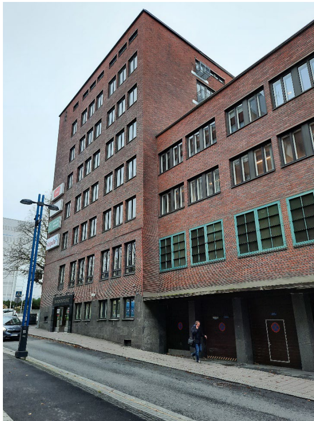
Kuva 3 Vasemmalla rakennusmassan pääosin säilyvä osa, oikealla purettava. Kuva Åkerlundinkadulta Tampere-taloa kohti. Valokuva vuodelta 2020.
